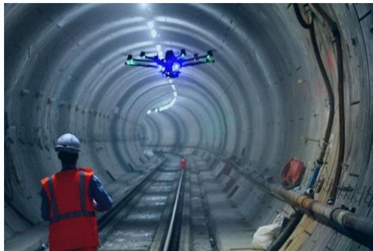
无人机隧道测绘作业
